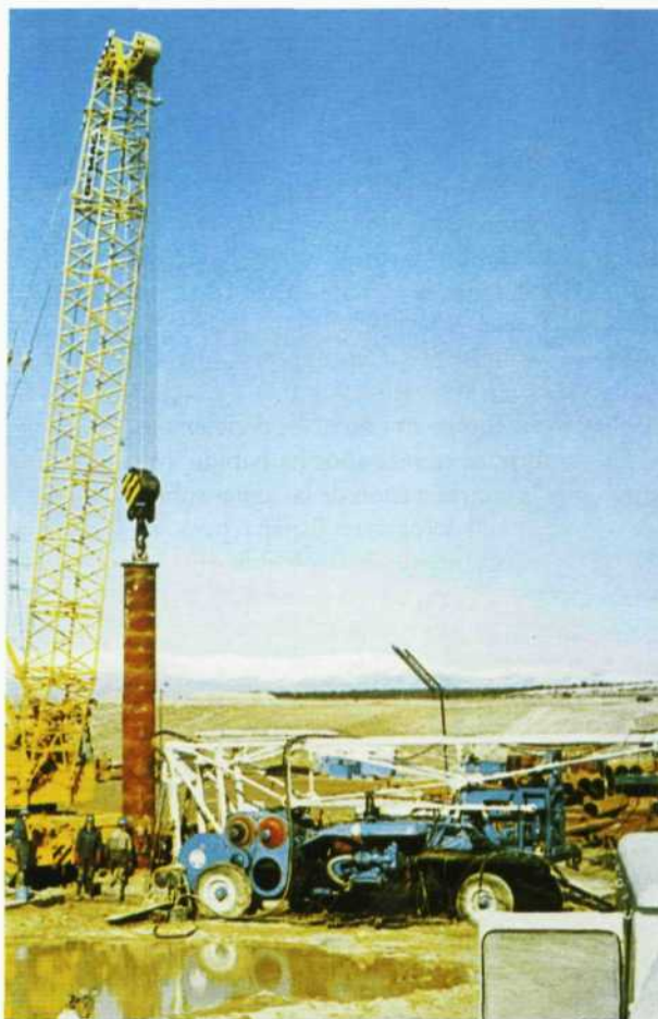
Fig. 2.— Colocación de la rejilla de un pozo profundo para el abastecimiento de Madrid. (Foto: García Agustín, 1974).
