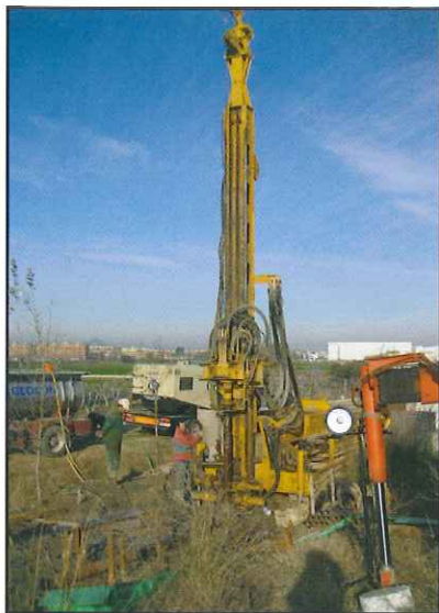
Perforación de un pozo en una zona deltaica.
