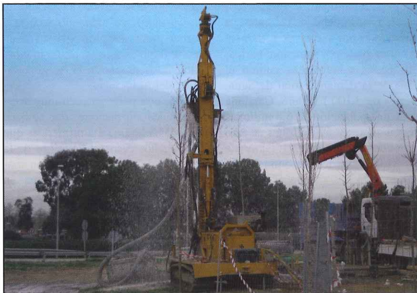
Perforación para captar aguas subterráneas.
