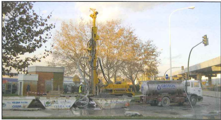
Perforación de un pozo en una zona industrial.
