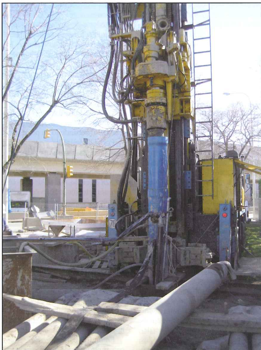
Máquina para perforar el subsuelo.
