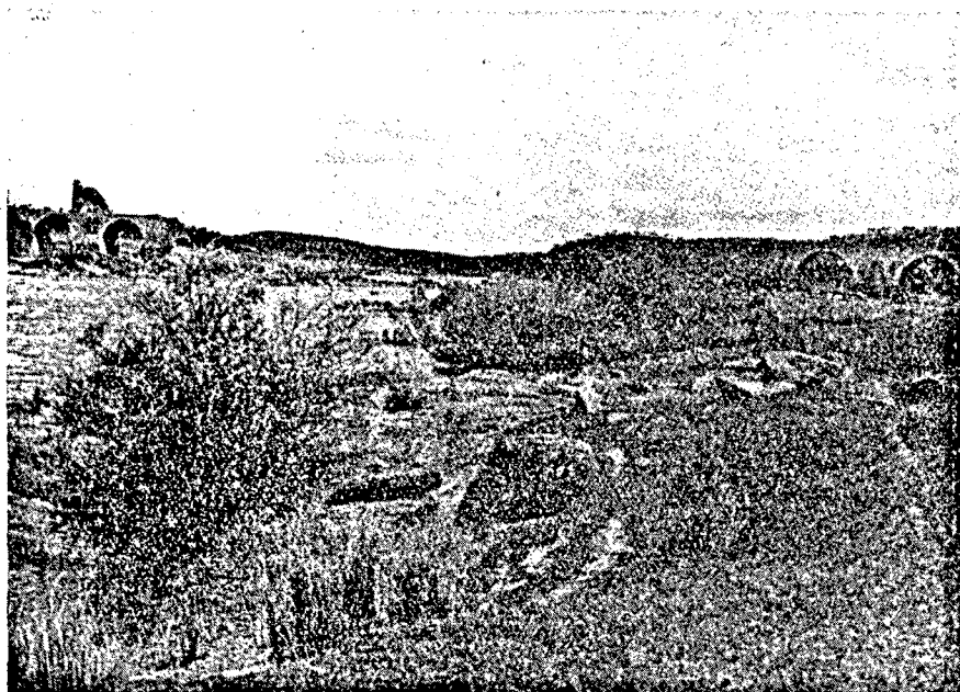
Fig. 199.—Puente internacional de Ajuda sobre el Guadiana, próximo a Olivenza (Badajoz), con la zona media del puente derruida por las avenidas
