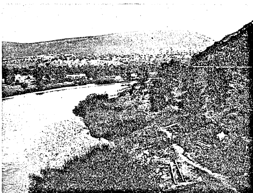
Fig. 106.—El Guadiana en el portillo de Cijara (Badajoz), paraje de ubicación de la gran presa para embalse de regadío.
