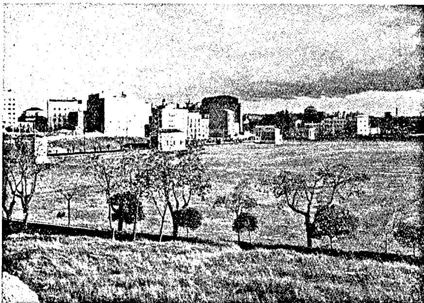
Fig. 185.—Depósito subterráneo de aguas del Lozoya en el barrio alto de Madrid para abastecimiento de la ciudad.
